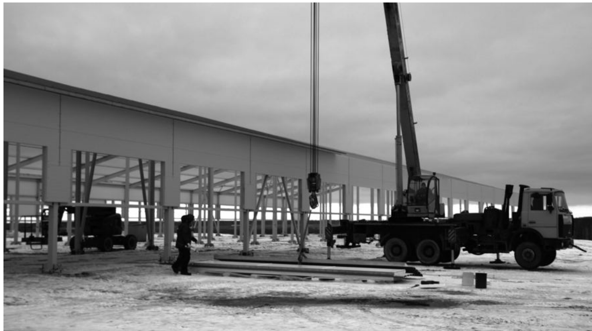
Строительство молочного комплекса в СПК им. Жукова.
